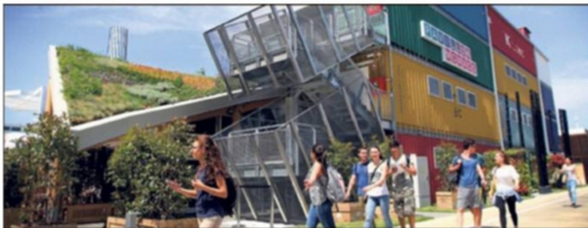
Des éléments du Pavillon de Monaco lors de l'Expo internationale de Milan ont été acheminés pour servir à la construction d'un centre polyvalent de formation et d'hébergement. (Photo J.-F. Ottonello)
